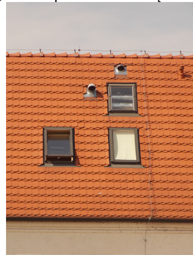
Fot 13 , Fot 14. Dach od strony dziedzińców kryty blachodachówką
