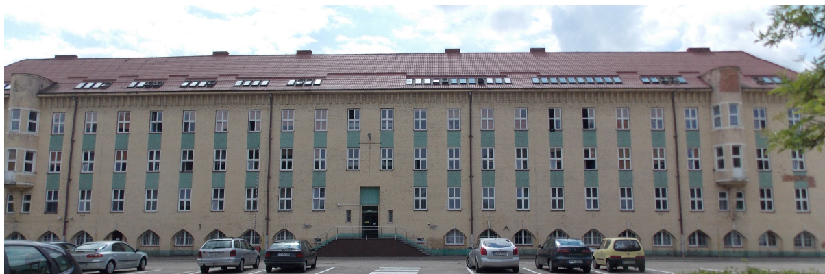
Fot 2. Elewacja od strony placu manewrowego północno-wschodnia
