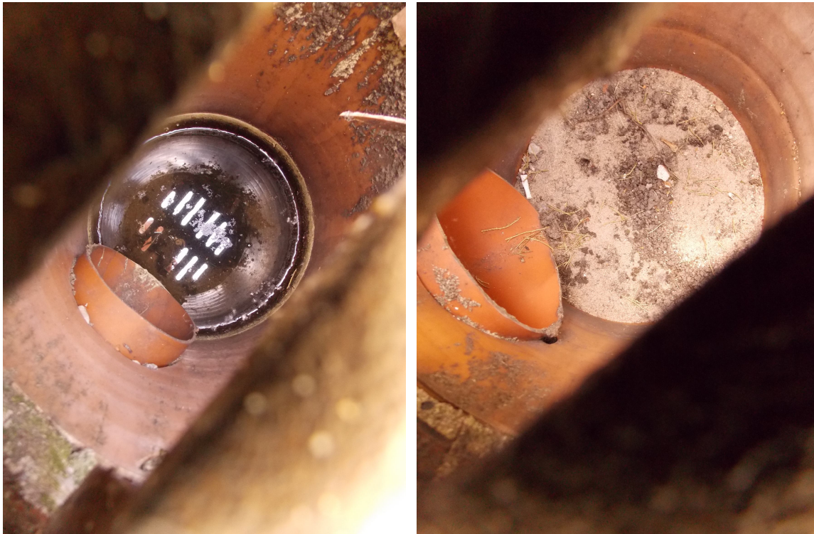
Fot 23 , Fot 24. Kanalizacja deszczowa dziedzińców , widoczne nowe rury PCV
