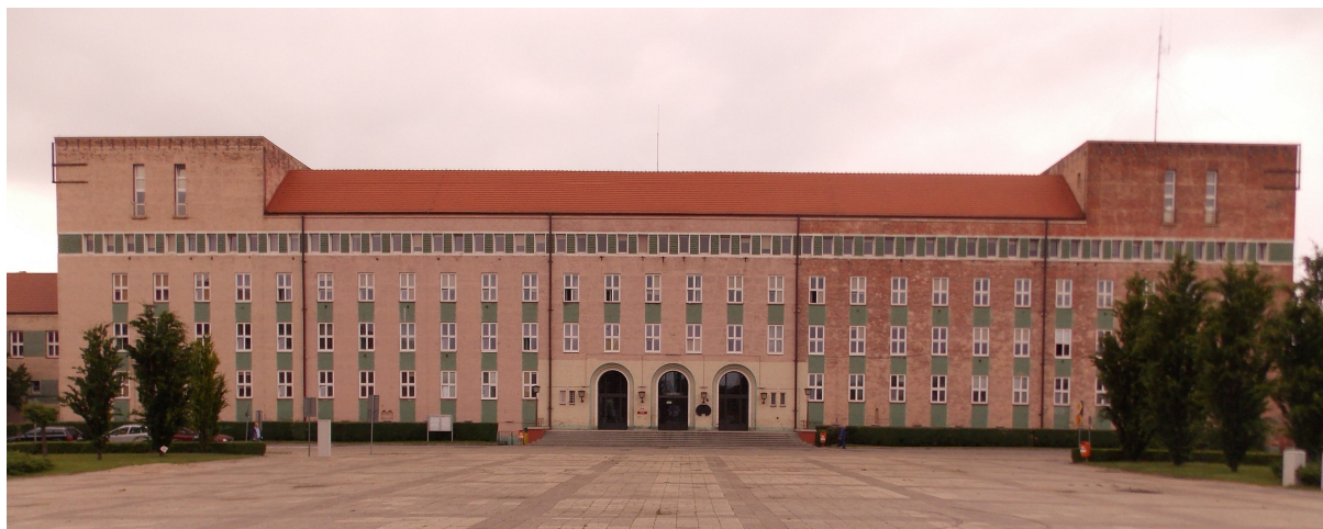
Fot 1. Elewacja frontowa południowo zachodnia
