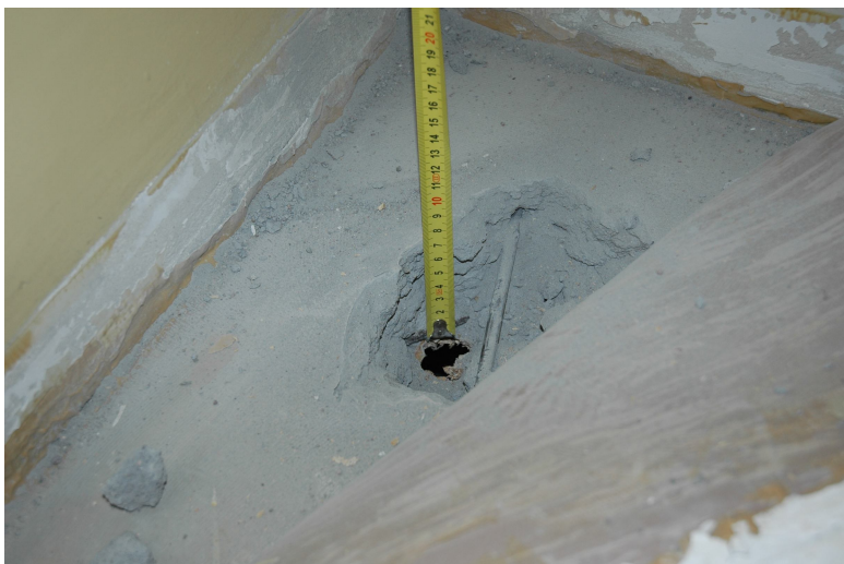
Fot 19 , Fot 20. Odkrytki w płytach żelbetowych
