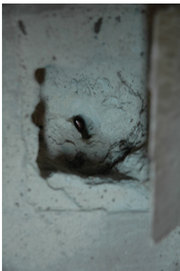
Fot 17 , Fot 18. Odkrytki w stropie Akermana
