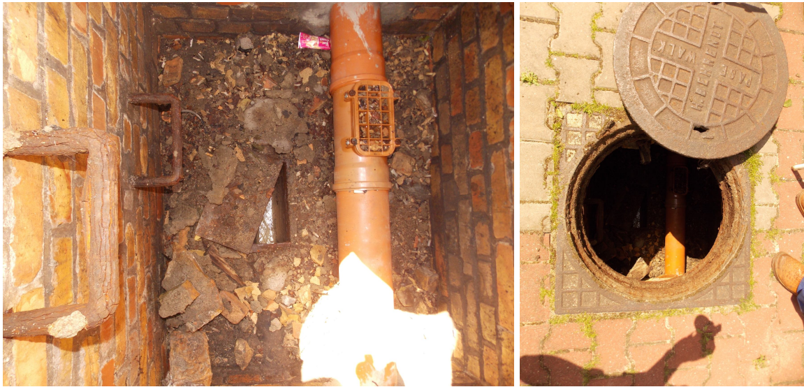
Fot 21 , Fot 22. Kanalizacja deszczowa dziedzińców , widoczne nowe rury PCV
